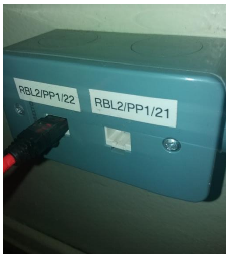
Fig. 7: Ponto de rede x2 devidamente identificado.
